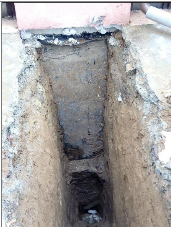
Fig. 1 – Fundația clădirii principale a SCM
