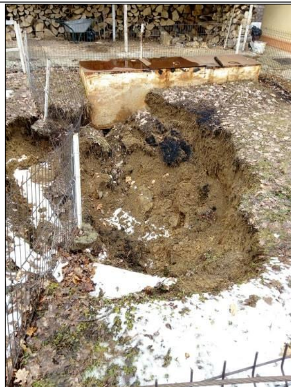
Fig. 2 – Rezervoarele de apă ale SCM
