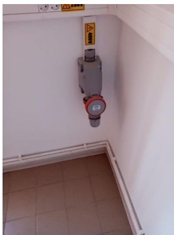
Figura 1b. Sistem de alimentare electric de tip trifazat (380 v)
