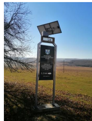
Figura 2c. Modificarea sistemului de iluminare a totemului stațiunii din centrul localității Mădârjac
